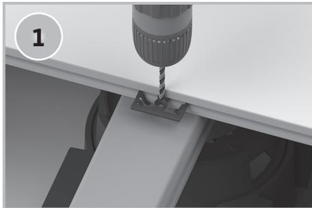
Clip bzw. Randclip mit Anschlag anlegen und mit 3 mm Bohrer vorbohren.
